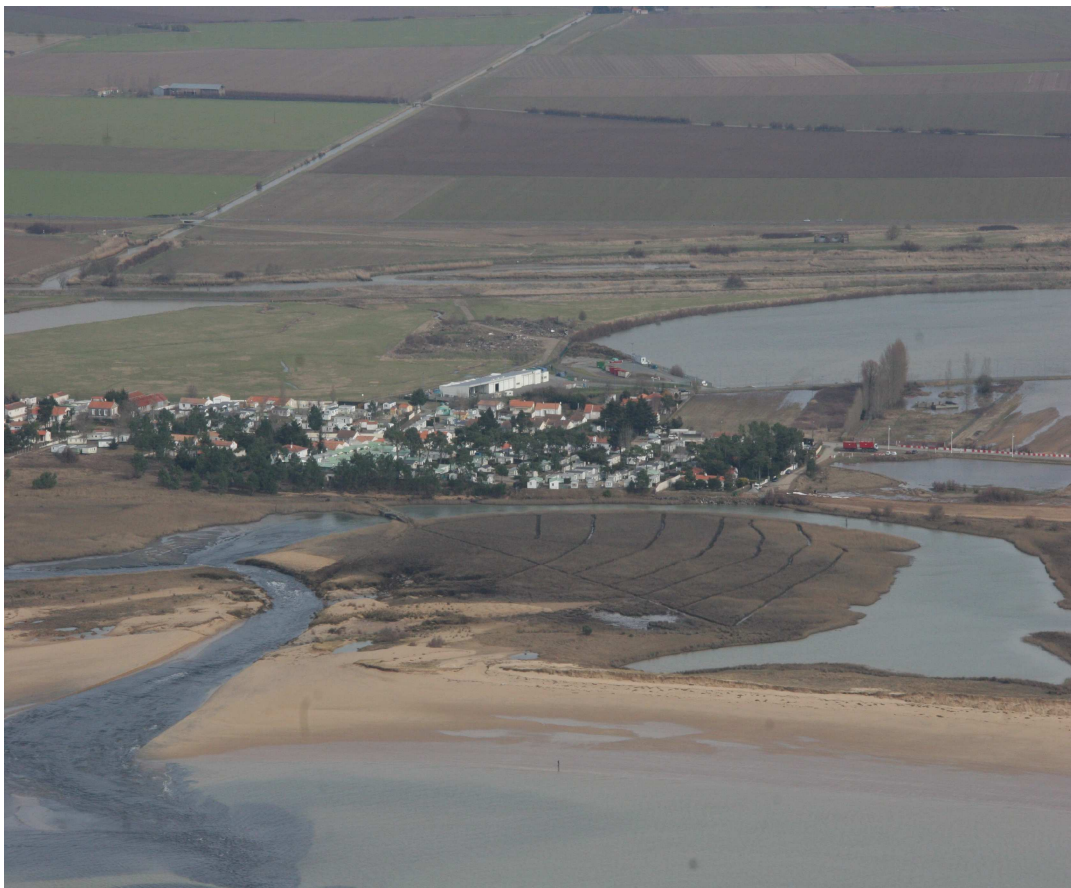
Lagune de la Belle Henriette suite au passage de Xynthia
